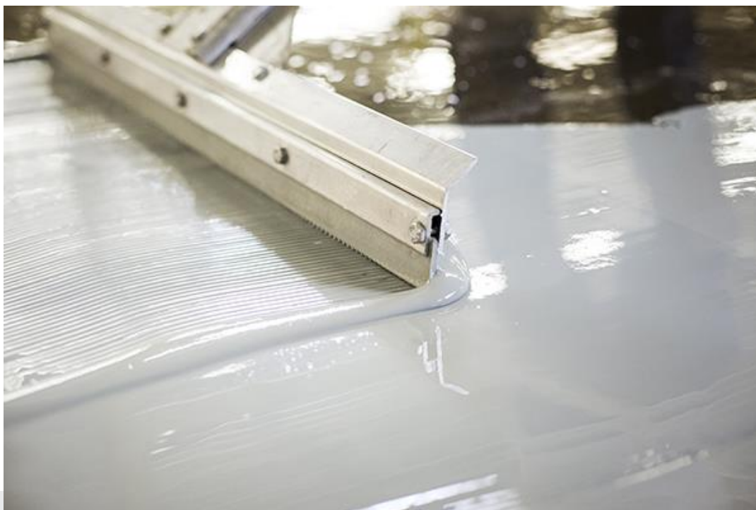
Foto: Aanbrengen vloeistofdichte beschermlaag.
