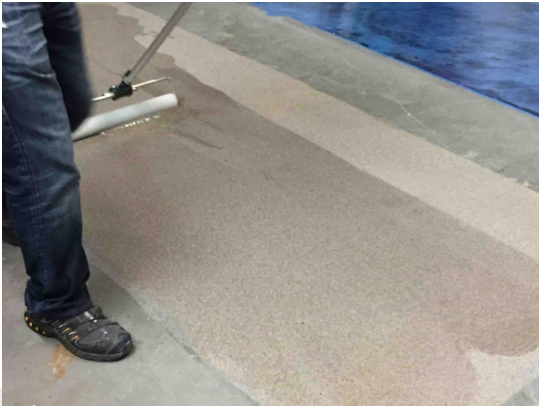
Foto: Aanbrengen primer.
